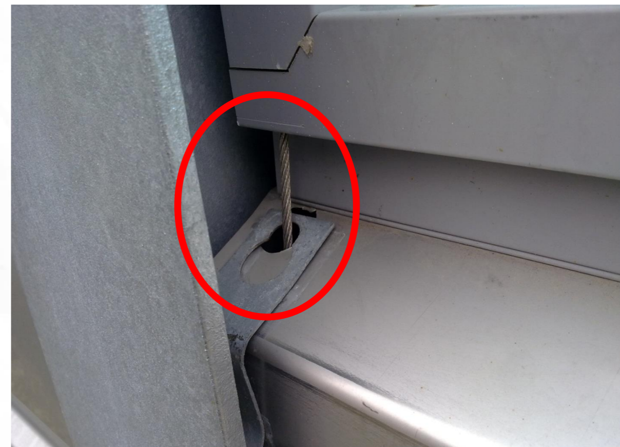
Вид с задней стороны АЭ. Панели стянуты между собой и прикреплены к стойке.
